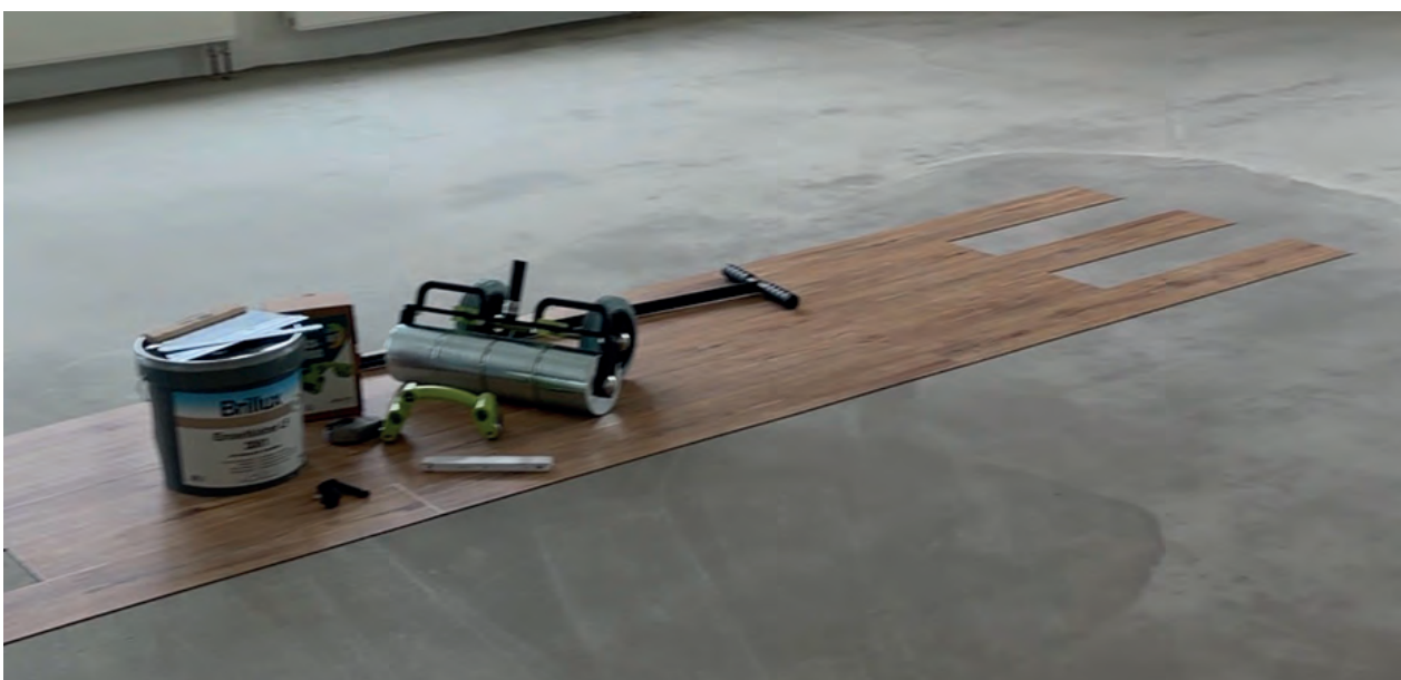
Der gesamte Boden ist eine glatte schöne Masse geworden. Ein Muster des Bodens ist bereits verlegt.
