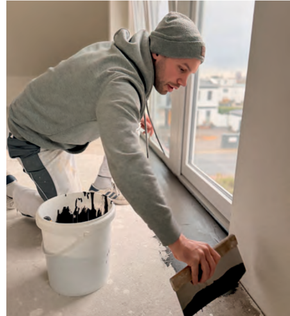
Unebenheiten werden vorab mit Ausgleichsmasse beseitigt.
