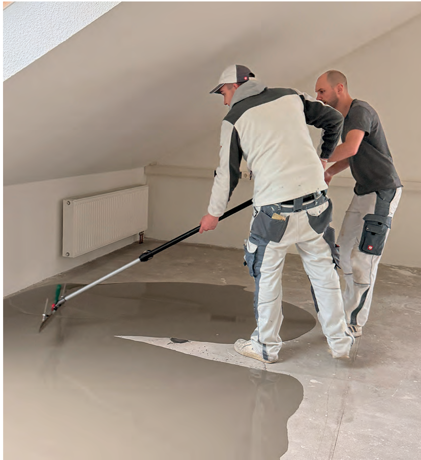
Nivelliermasse verstreichen, möglichst schnell und gleichmäßig – eine echte Herausforderung.
